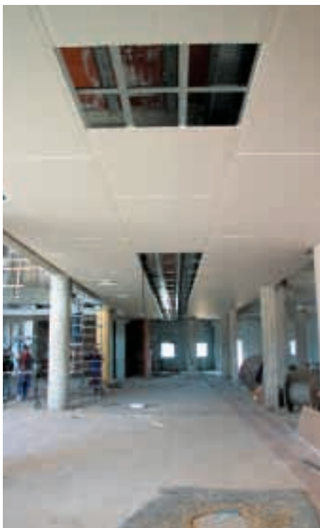
Nelle immagini: il cantiere in corso d'opera del nuovo multisala
